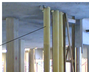
tubi di scarico isolati con cospelle in lana di roccia
